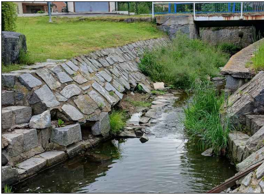
Vzorová fotografie degradovaného opevnění v místě vzorové řezu
