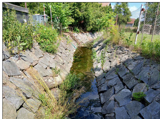
Vzorová fotografie degradovaného opevnění v místě vzorové řezu
