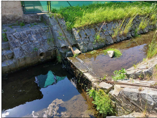
Vzorová fotografie degradovaného stupně v místě vzorové řezu
